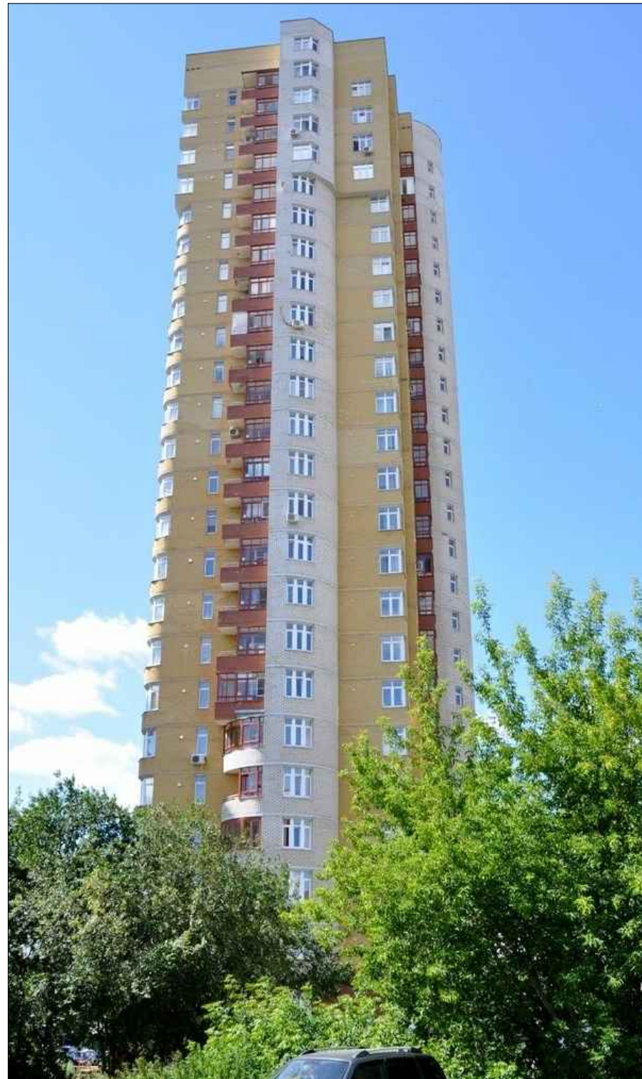
Фасад по ул. Профсоюзная
